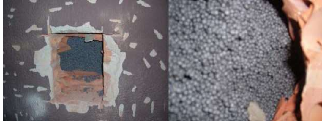
Injection of EPS with graphit from the outside Agència de l'Habitatge de Catalunya
